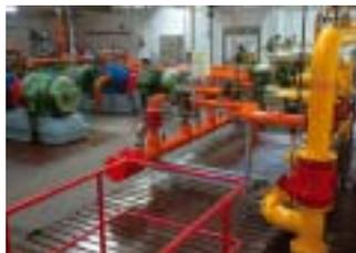
In der Gasverteileranlage wird das Gas ins Verteilernetz gespeist.
