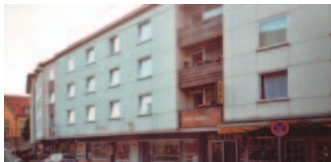
Bild oben: Das Hotel Vis-à-vis, neu und mit einer ansprechenden Farbgestaltung der Fassade. Bild unten: Das Hotel vor der Verwandlung.
