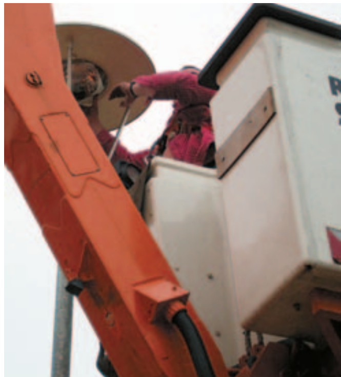
Von den Stadtwerke-Mitarbeitern werden regelmäßig defekte Lampen repariert.
