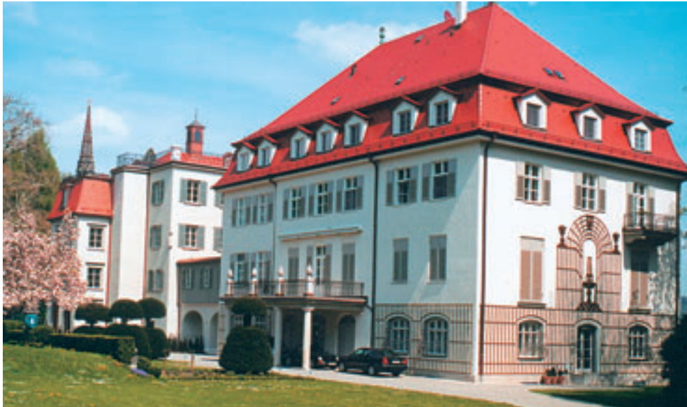
Das alte und neue Schloss Moos erstrahlt nach der Sanierung in neuem Glanz.
