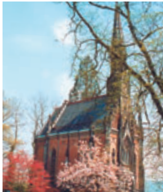
Auch die Kapelle von Schloss Moos wird im Zuge der Baumaßnahmen saniert.
