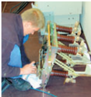
Reinigung des 10.000V-Hochspannungsschalters
