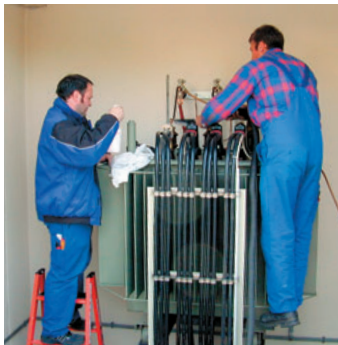
Reinigung und Überprüfung des Ortsnetztransformators
