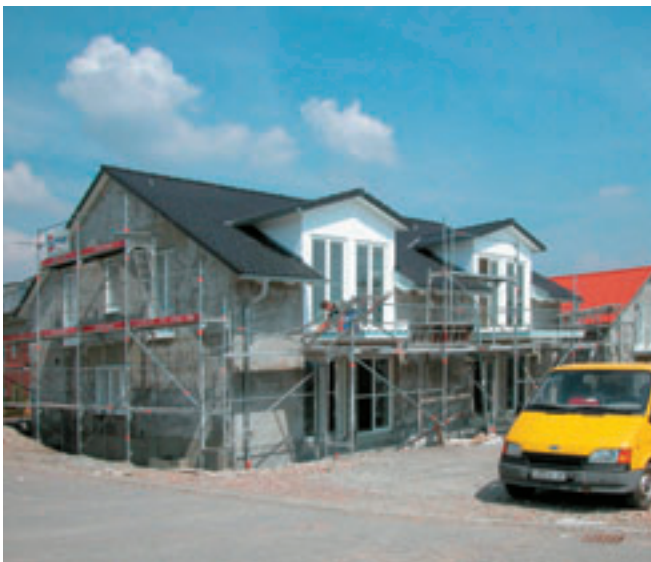
In wenigen Wochen werden diese Häuser fertig gestellt sein. Die moderne Fensterfront bietet den direkten Blick auf das Schloss Moos.
