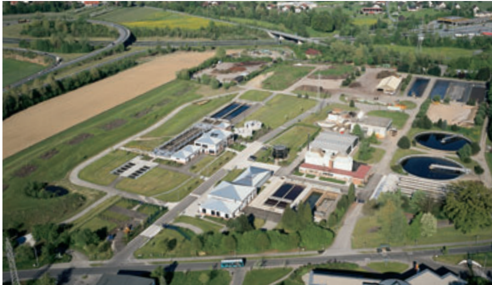
Das Klärwerk in Lindau-Zech von oben, gesehen von Südwesten, hinten die Autobahn-Anschlussstelle
