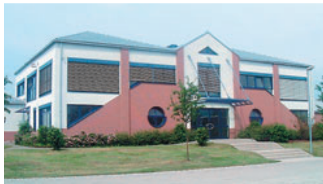
Das Lindauer Klärwerk – eine saubere Sache; hier das Betriebsgebäude
