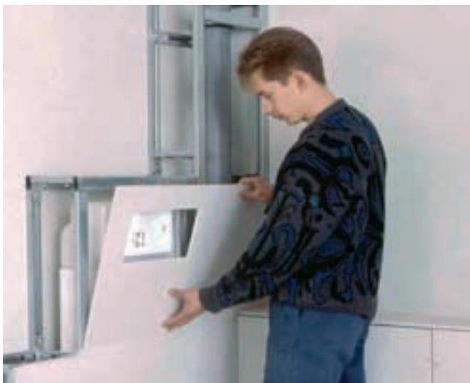
Die Verkleidungen mit Fermacellplatten sind auch für Feuchträume geeignet. Fermacell/Xella
