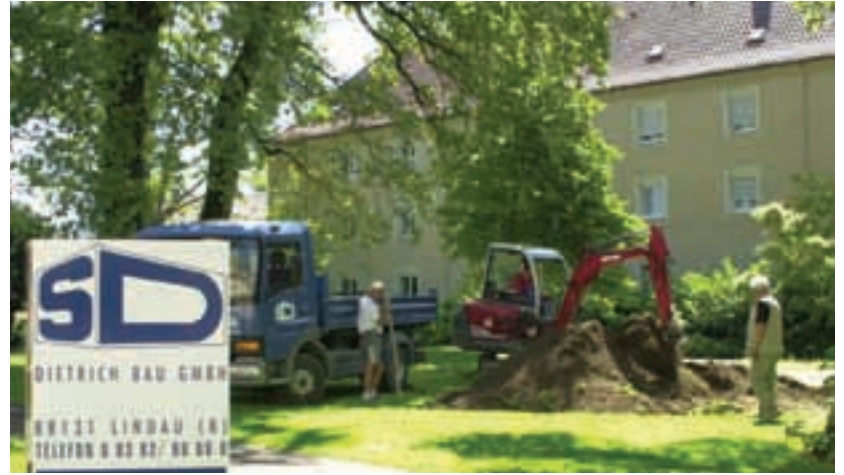
21.06.2005: Die Bagger beginnen mit der Arbeit für das Fundament des Musikpavillons am Buttlerhügel. BZ-Foto: AL
