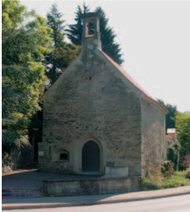
Nach der Sanierung erstrahlt die Krellsche Kapelle in altem Glanz.
