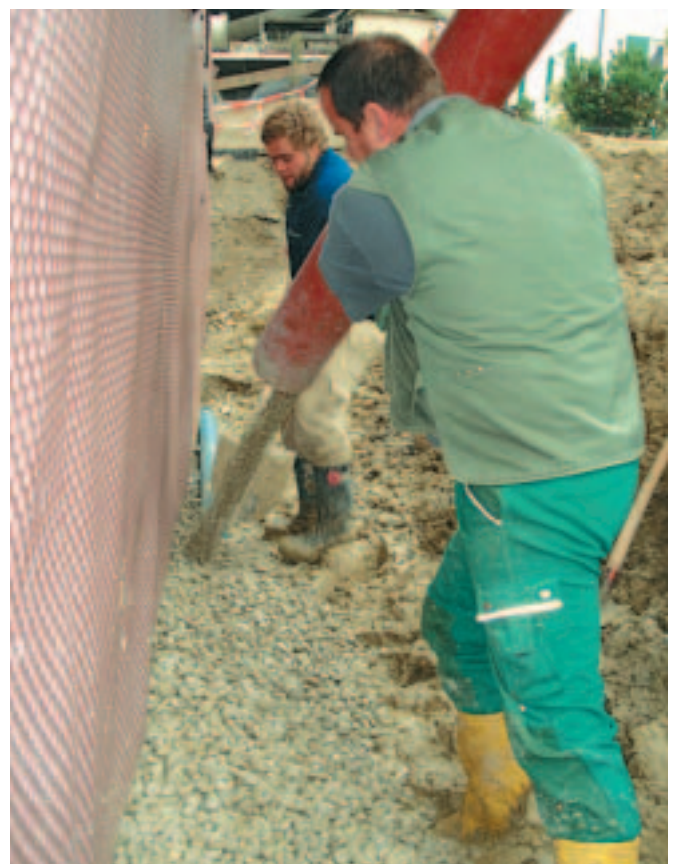
Auch Tiefbauarbeiten oder eine komplette Haustrockenlegung sind im Leistungsangebot von Garten- und Landschaftsbauer Alexander Munz.
