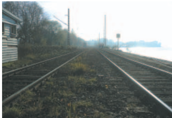
Eine mögliche Öffnung des Eisenbahndammes für den Autoverkehr hat der Stadtrat mit 17:13 Stimmen abgelehnt. Somit werden in naher Zukunft keine Autos über den jetzigen Bahndamm fahren. BZ-Foto: STS
