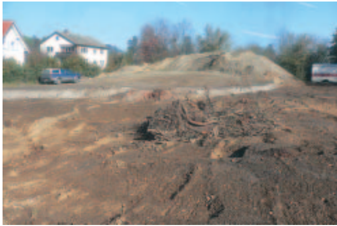
Wo sich Anfang November 2006 noch Kies und Erde auftürmen, werden bald zwei Doppelhäuser entstehen. BZ-Foto: STS
