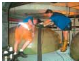
Die Filter- und Wasseraufbereitungsanlage wurde komplett entleert, gereinigt, desinfiziert und neu befüllt.
