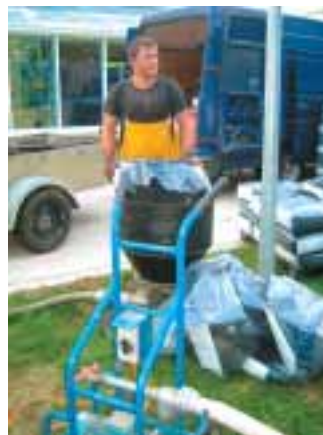
20 Tonnen Kohle und Kies wanderten in die gereinigte Filteranlage.
