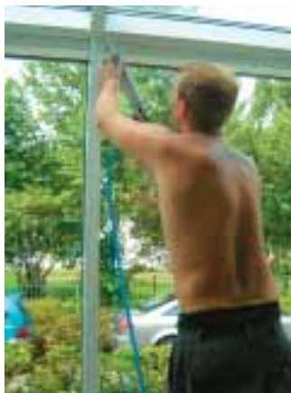
Die Fenster wurden neu abgedichtet, das spart zukünftig Energie.
